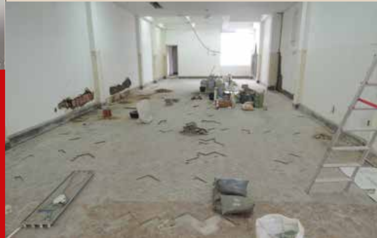
RIO DE JANEIRO 2016. Démolition, aménagement interieur, design lumière et mobilier
